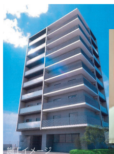
■ 社員寮新設を決定 (2026年2月完成予定)
