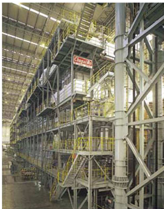
冷延鋼板連続焼鈍設備 (CAL)
