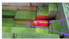
都市ガス用バーナ構造における水素燃焼時の様子
