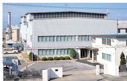
図 1 燃焼研究所 外観。
