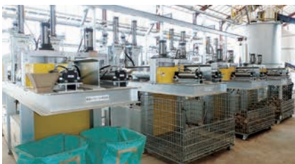
秋田県横手市向けバイオコークス製造設備
