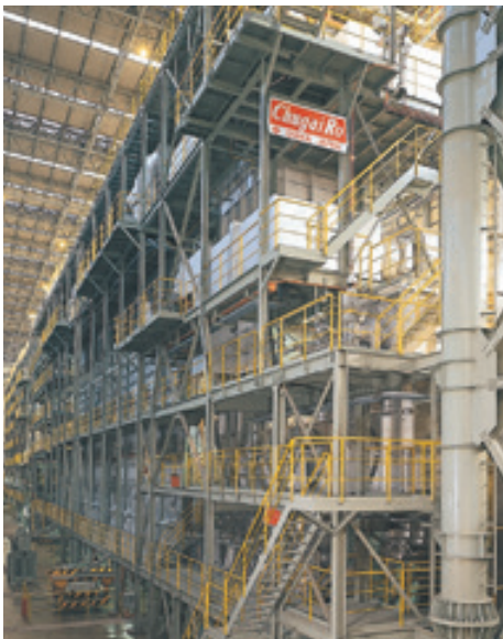
冷延鋼板連続焼鈍設備 (CAL)
