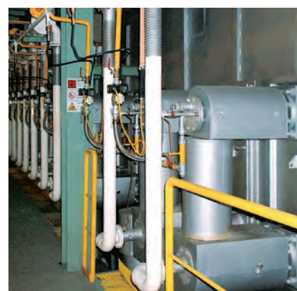
WRBG®型ラジアントチューブバーナ
